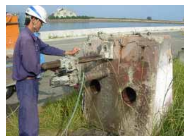
写真1 コンクリート試料採取風景
